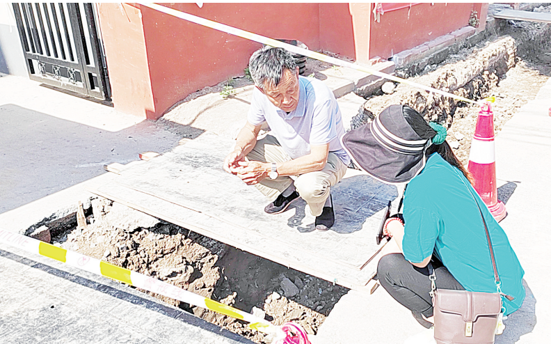
社区工作人员查看排水沟修建情况
