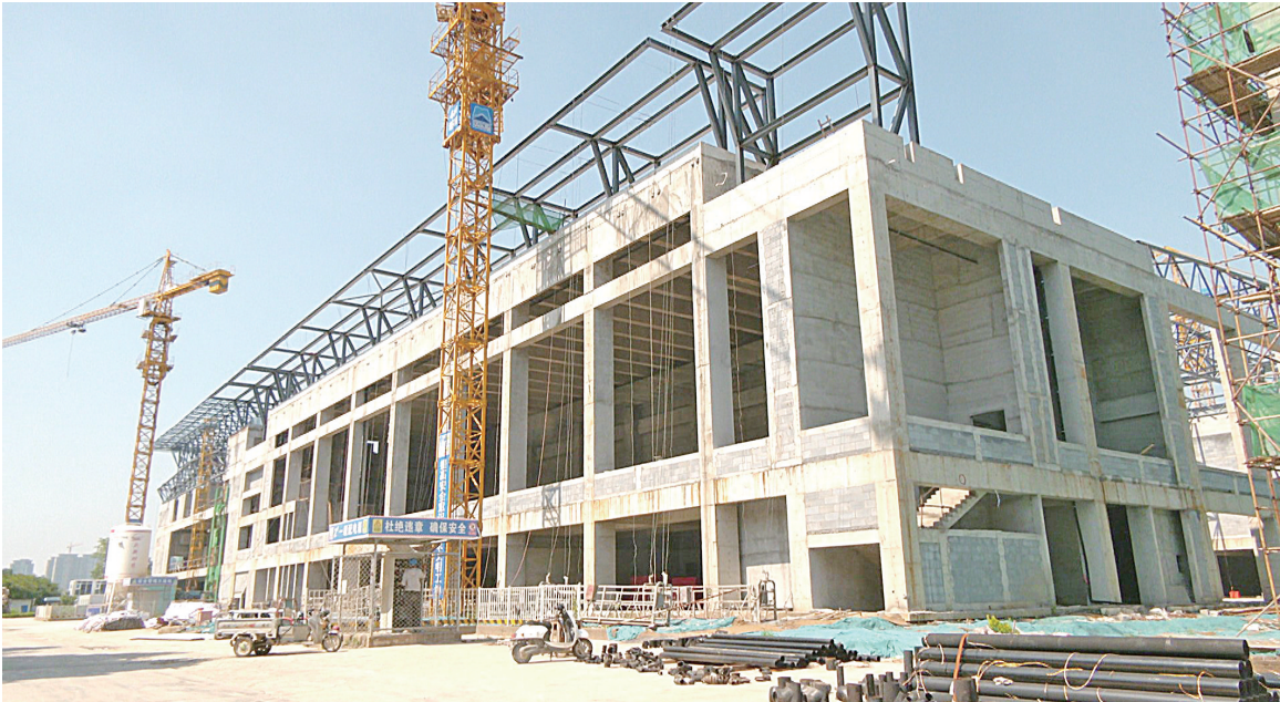
内黄县文化体育图书馆项目建设现场(李山有 摄)
