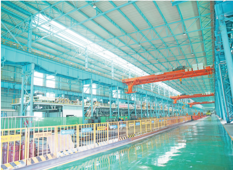
安钢冷轧先进的生产线
