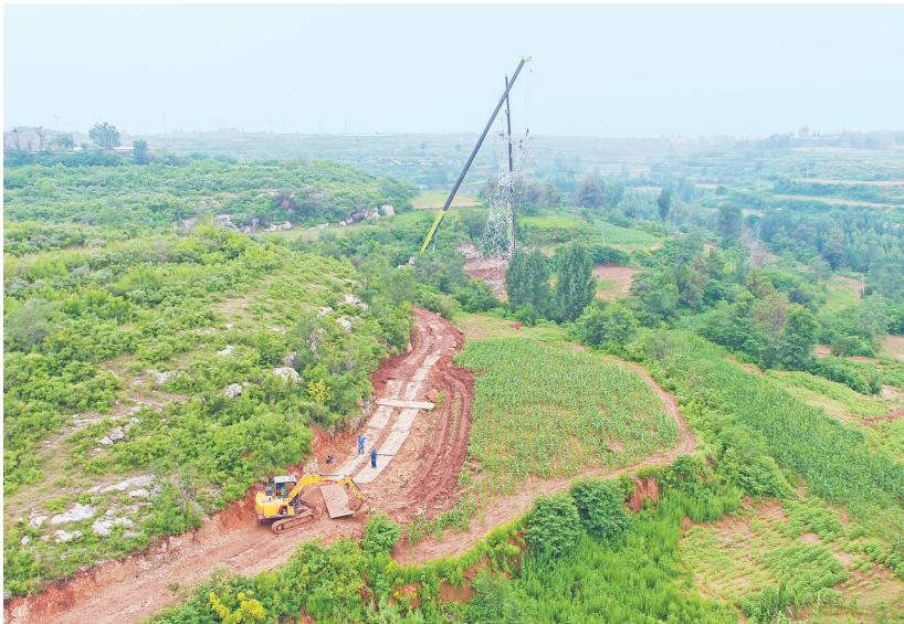
7月11日,220千伏I彰桃线33号塔塔抢修现场航拍(张阳摄)
