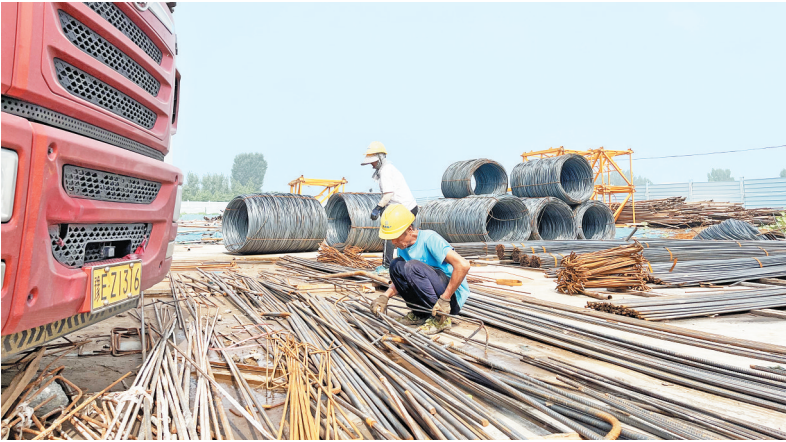
龙骏高中项目建设现场，工人正在紧张作业（本报记者 申昕 摄）
