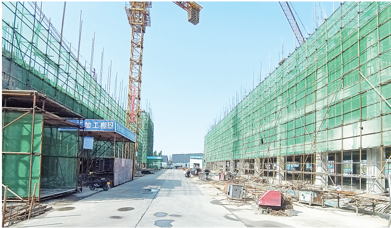
项目建设现场(李志伟 摄)
