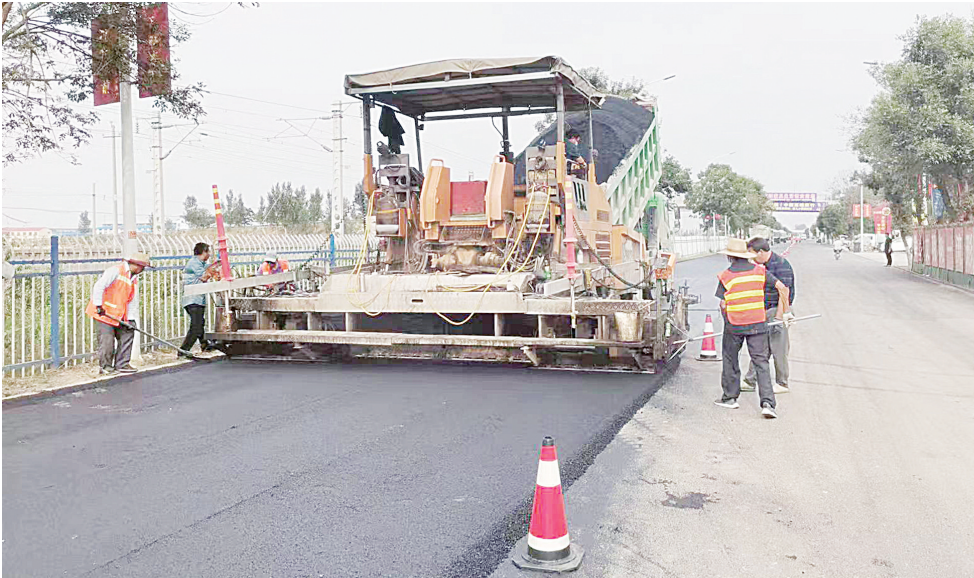
S303(濮安线)道路重建修复现场(资料图)
