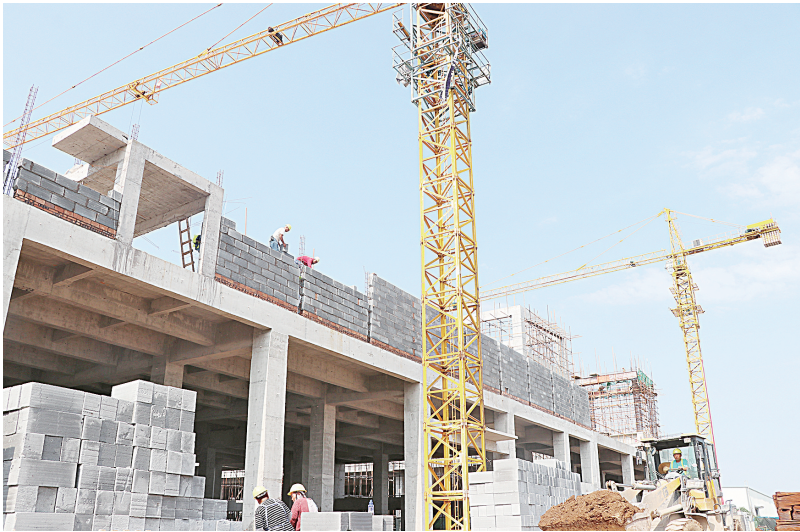
致远电子二期项目建设现场
