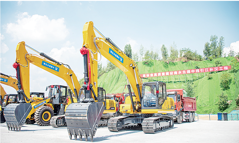
7月7日在引江补汉工程开工现场拍摄的施工机械(新华社记者 伍志尊 摄)
