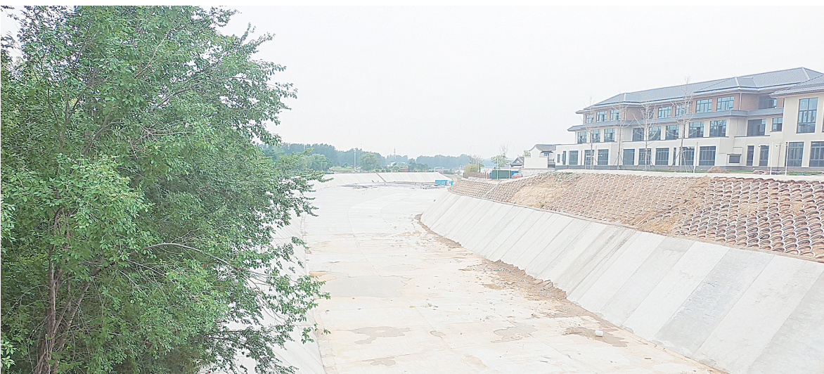
姜河水毁工程灾后恢复重建项目
