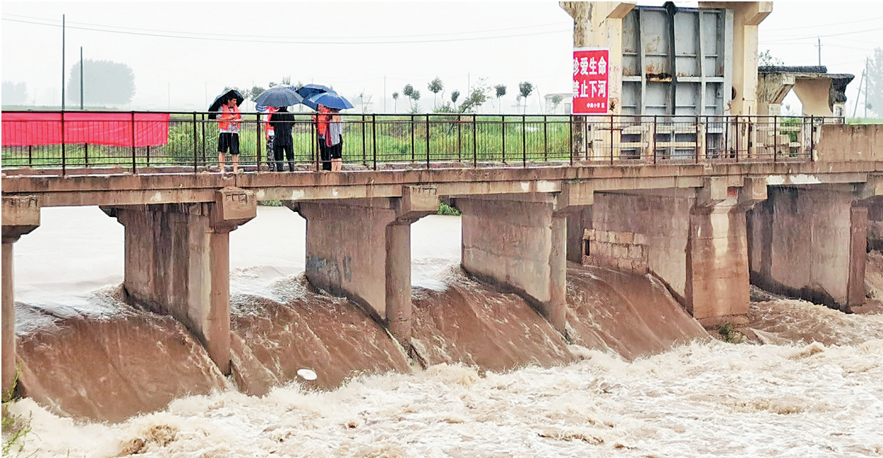
县水利局工作人员在郭盆闸现场指导安阳河河道行洪(周重阳 摄)
