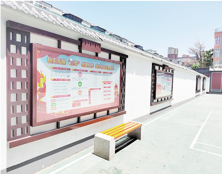
梅园庄街道北辛庄社区老旧小区改造完成后的公共墙体
