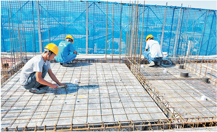
殷都区棚改二期项目施工现场(殷都区住建局供图)
