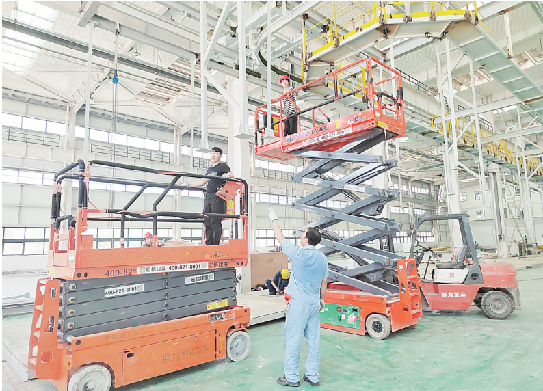
工人师傅在安装钢架主体结构(本报记者 郝亚伟 摄)
