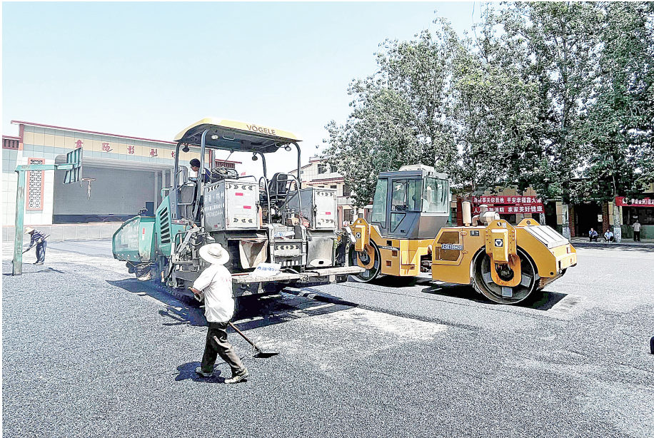
郝合兴的工程队在盘阳村铺柏油
