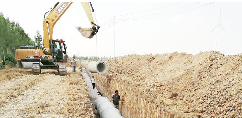
地下暗渠工程施工现场(本报记者 郭凡 摄)
