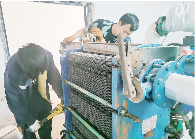
工作人员正在拆卸换热片(张承摄)
