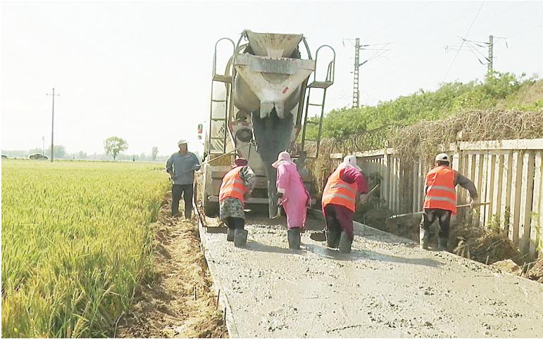
灾后重建水毁道路施工现场(张伟民 摄)
