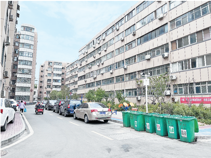
改造后的市机床厂家属院
