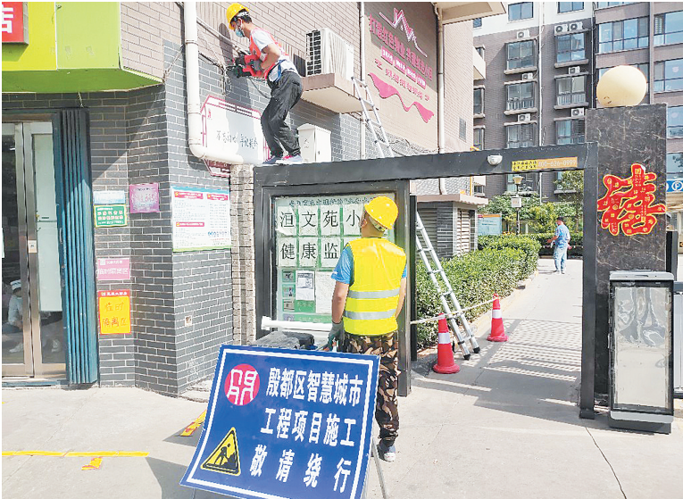
在纱厂路街道洹文苑小区，工人正在安装摄像头（秦鹏 摄）
