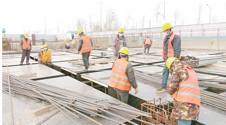
内黄县重点项目建设现场(彭志帅 摄)
