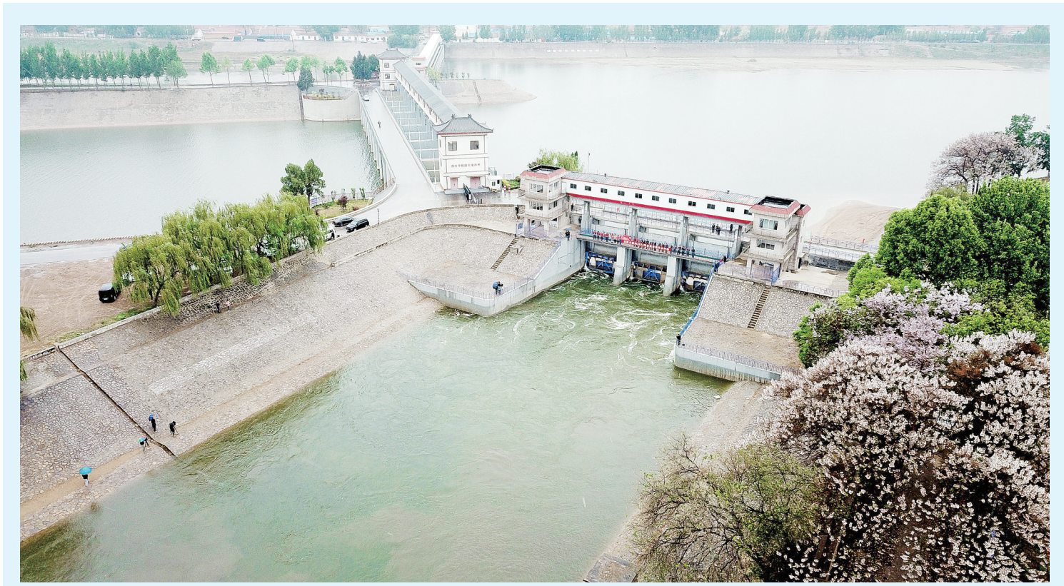
4月28日,山东省德州市四女寺枢纽南运河节制闸开启,对京杭大运河全线贯通补水(无人机照片)。
