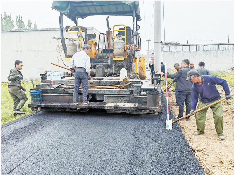
北张贾村户户通工程施工现场(本报记者 郭凡 摄)
