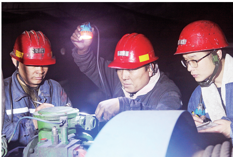
该矿机电专业小组正在井下检查设备安全状况(本报记者姚芳摄)
