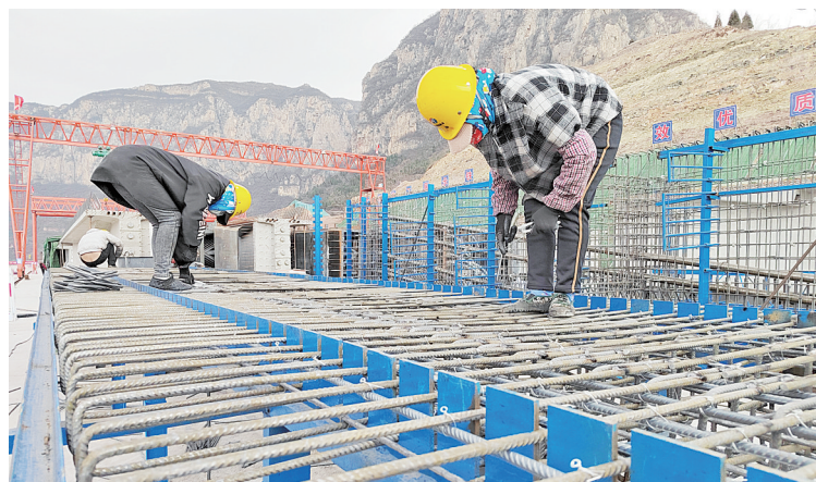
工人在沿太行高速公路安阳段施工
