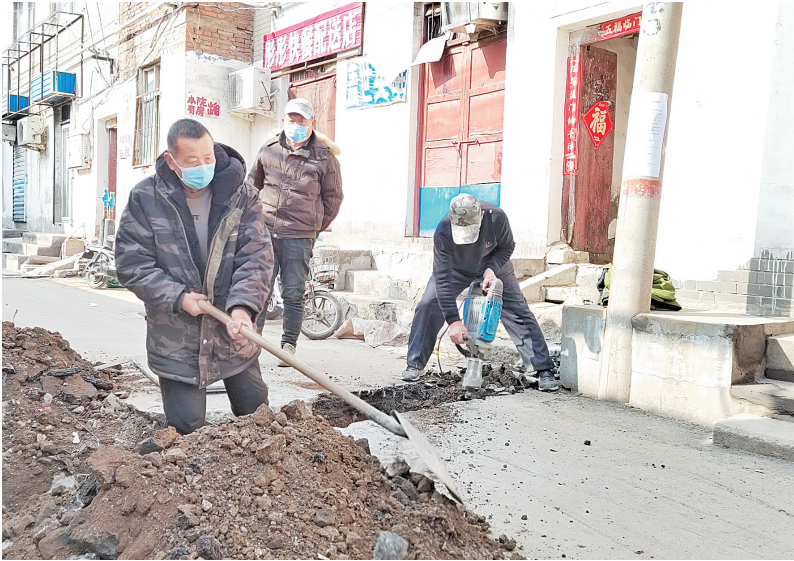
工人正在铺设暖气管道
