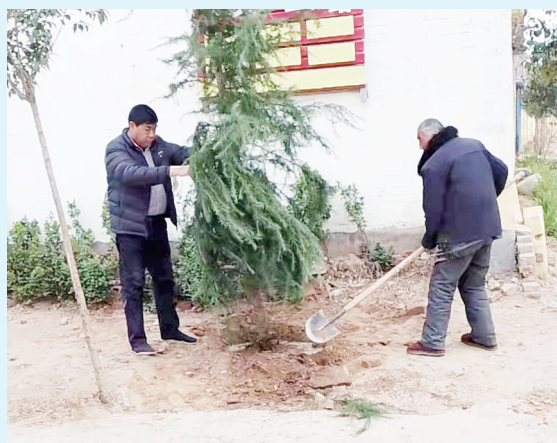
为改善农村人居环境,近年,半坡店镇闫河屯村持续开展清理囤村垃圾、治理私搭乱建、村庄道路提升、村庄绿化亮化等工作,积极营造清洁、优美、宜居的人居环境。图为3月22日,驻村第一书记齐尚山(左)和村民正在栽植街道景观树。(毕兴世 摄)
