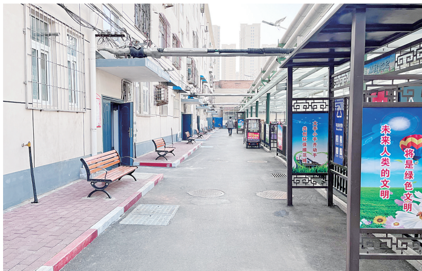
光辉路统建楼家属院改造后,面貌焕然一新
