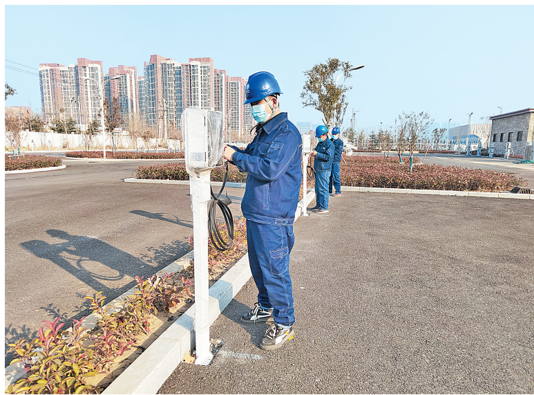
工人在新能源充电桩建设现场整理充电线(本报记者 高倩 摄)
