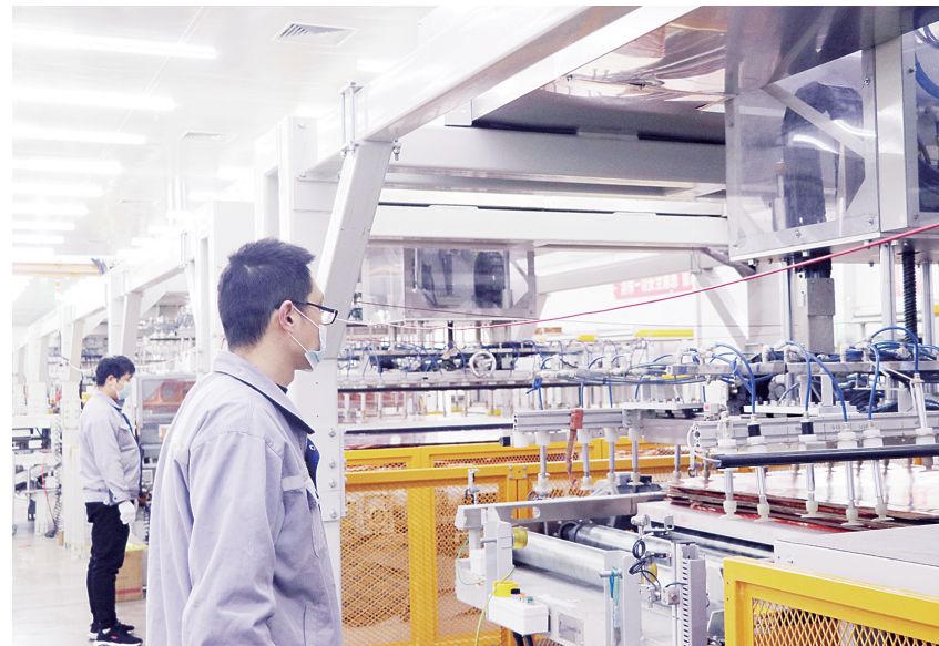
致远电子覆铜板生产线
