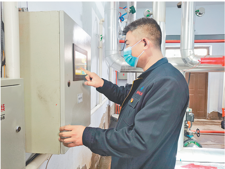
工作人员正在换热站调整相关供热参数(张承 摄)
