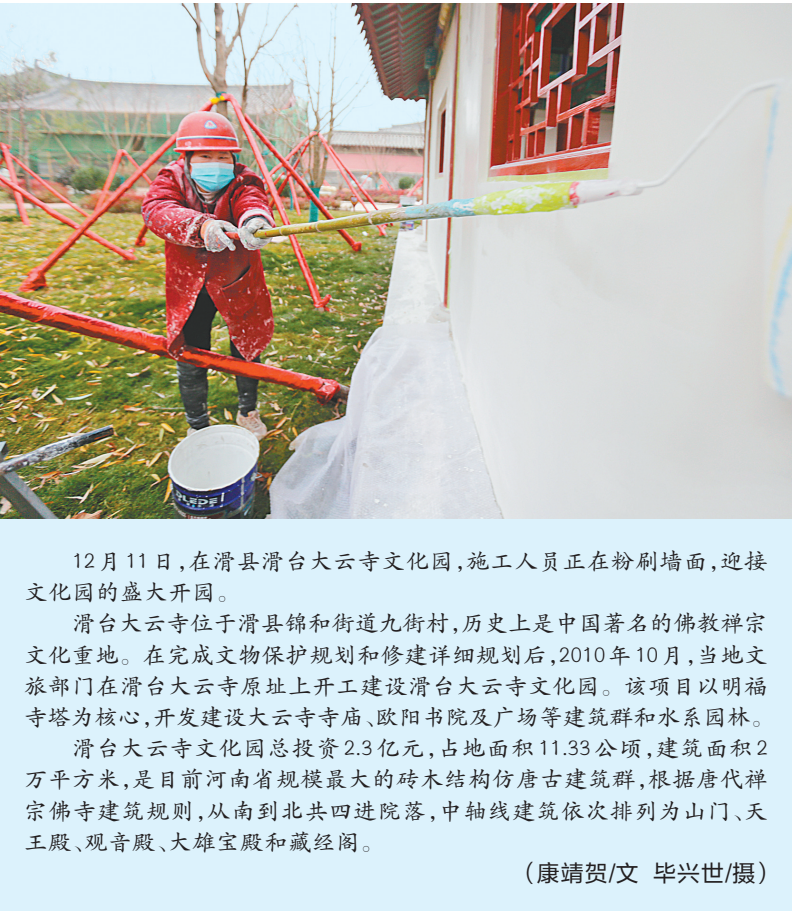
12月11日,在滑县滑台大云寺文化园,施工人员正在粉刷墙面,迎接文化园的盛大开园。
