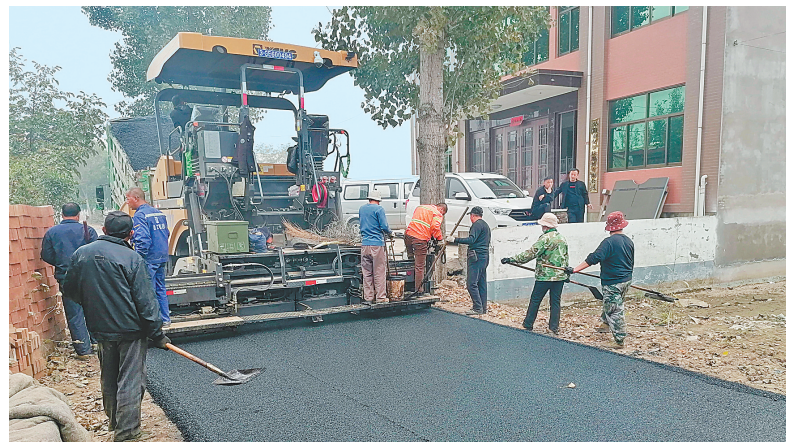
村中铺设柏油路现场(乔光 摄)
