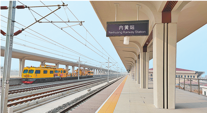
郑济高铁内黄段轨道铺设已全部完成
