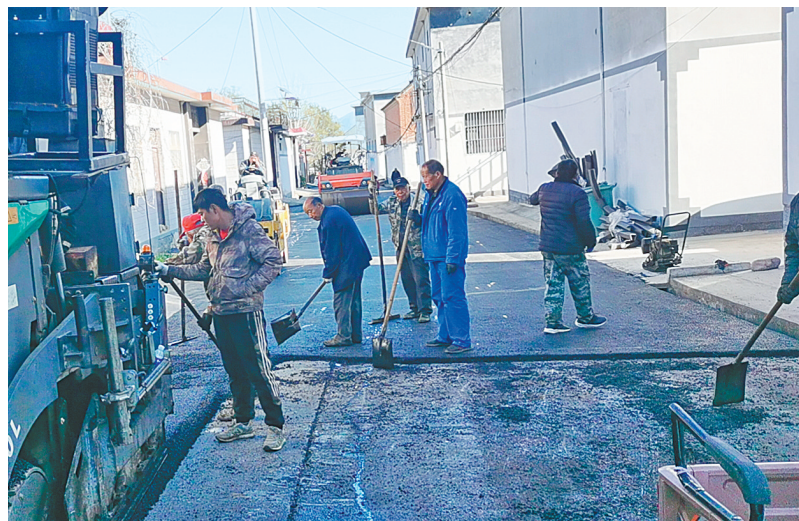
干部群众与筑路工人在铺柏油
