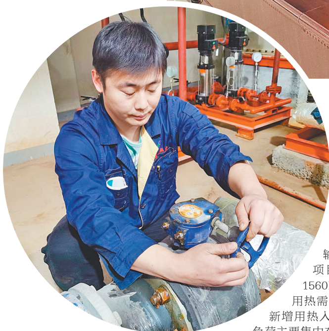
↑工作人员正在调试管网循环阀门(本报记者 姚芳 摄)
