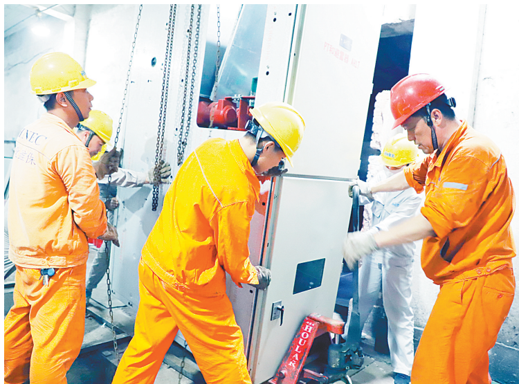
10月18日,员工正在拆解搬运旧汽轮机电控设备(王晓军 摄)
