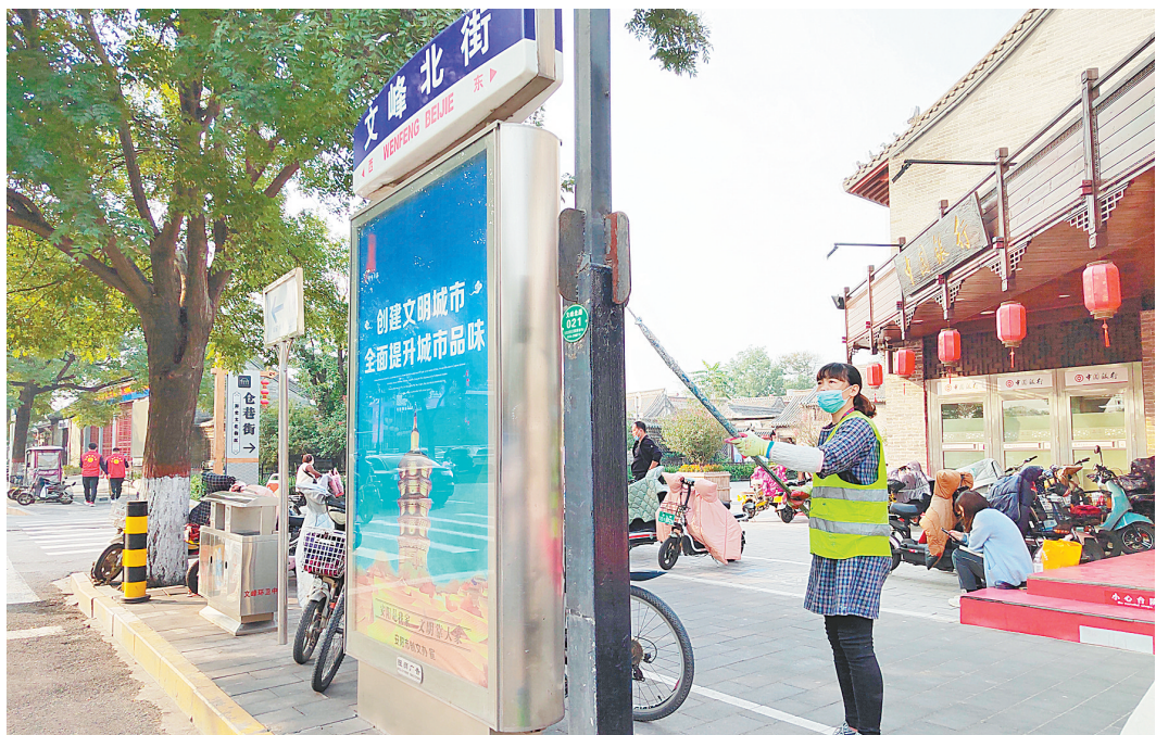
工作人员在油漆灯杆(本报记者 邓娟 摄)
