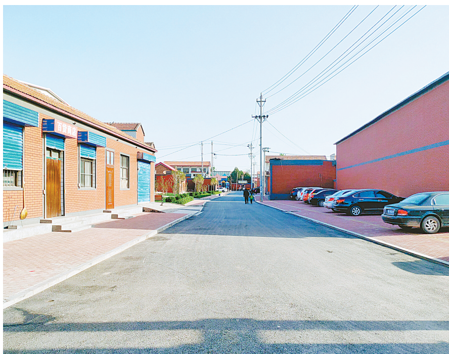
南子针村污水管网铺设完工的路面
