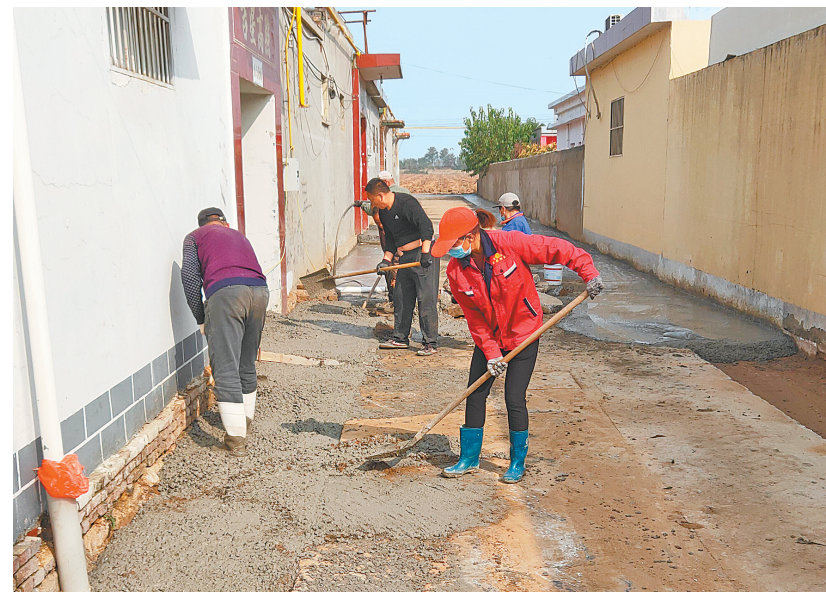
“户户通”工程施工现场(本报记者 郭凡 摄)
