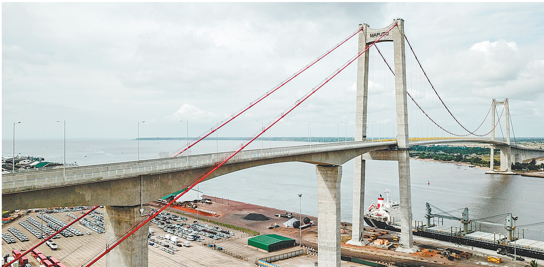
这是2019年4月8日在莫桑比克拍摄的马普托大桥(无人机拍摄)。2018年11月,由中国路桥工程有限责任公司承建的马普托大桥及连接线项目经多年建设正式通车,莫桑比克人多年夙愿终于实现。无论是从历史维度还是使用寿命而言,马普托大桥都可以被称为“百年工程”。这座“梦想之桥”是莫桑比克总统口中的精品工程,更是民众眼中的城市新名片。(新华社记者 张宇 摄)
