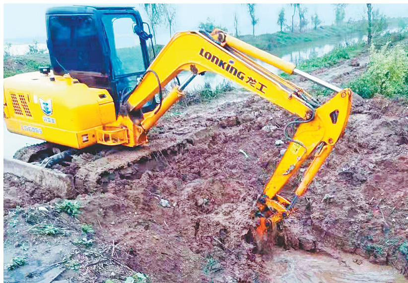
瓦店乡党员驾驶机械在广润坡挖沟排涝
