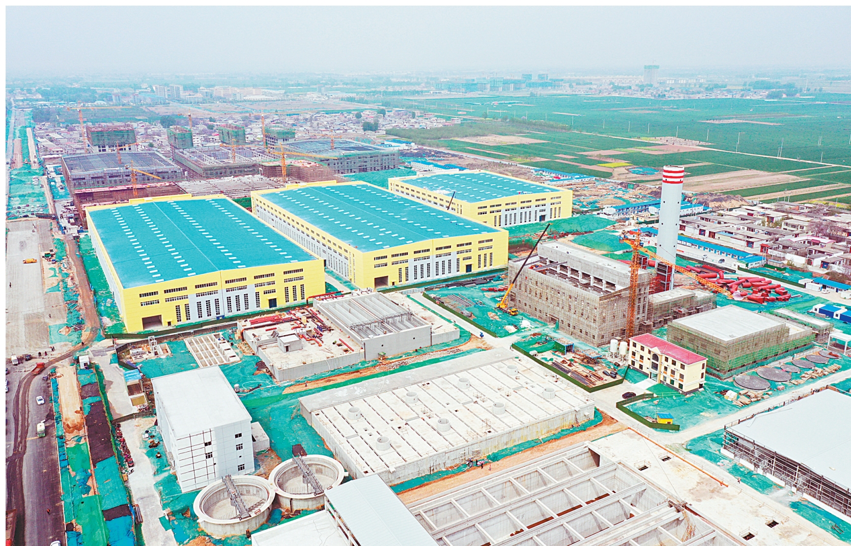
中信印染示范园项目
