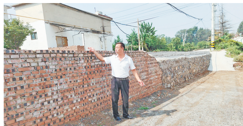
杨用海介绍村庄道路护坡修复情况
