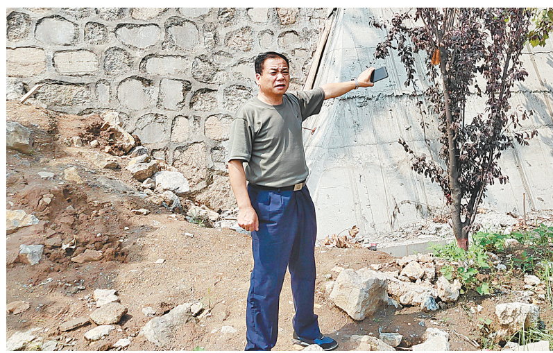
顺成集团政策研究室主任李志明介绍项目道路护墙修复情况
