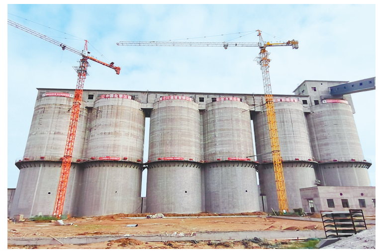
内黄县陶瓷园区清洁工业燃气集中供气项目建设现场(项目方供图)
