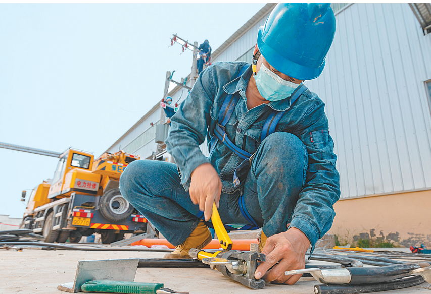
8月28日，国网滑县供电公司电力工人刘增生正在压接线夹(王亚方 摄)
