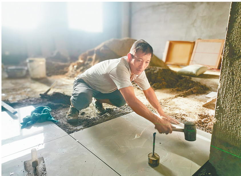
安阳市合金新材料产业园中一栋已交付厂房正在进行室内装修
