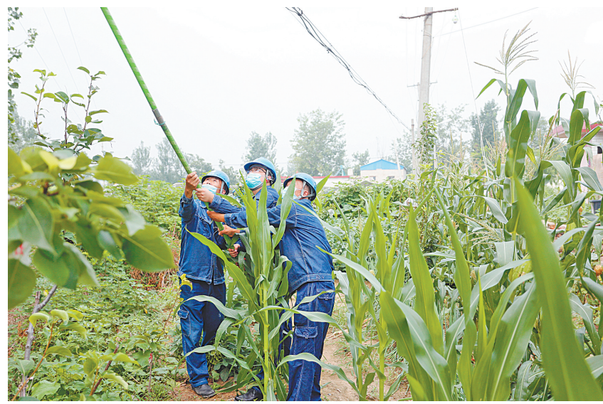
电力抢修现场(谢志鹏 摄)
