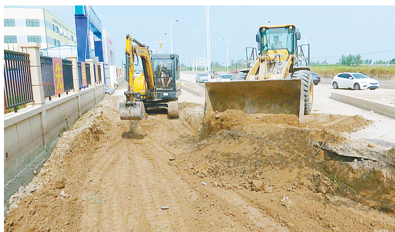
二安镇道路抢修现场(张伟民 摄)
