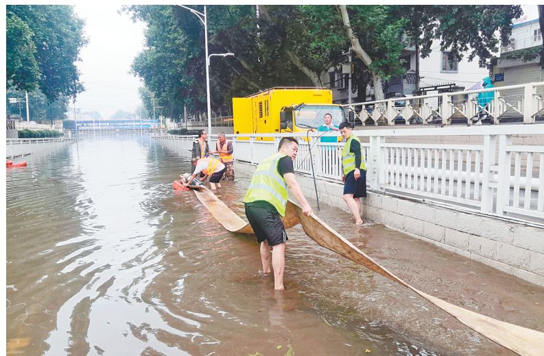
市政维护人员正在进行抽排水作业
