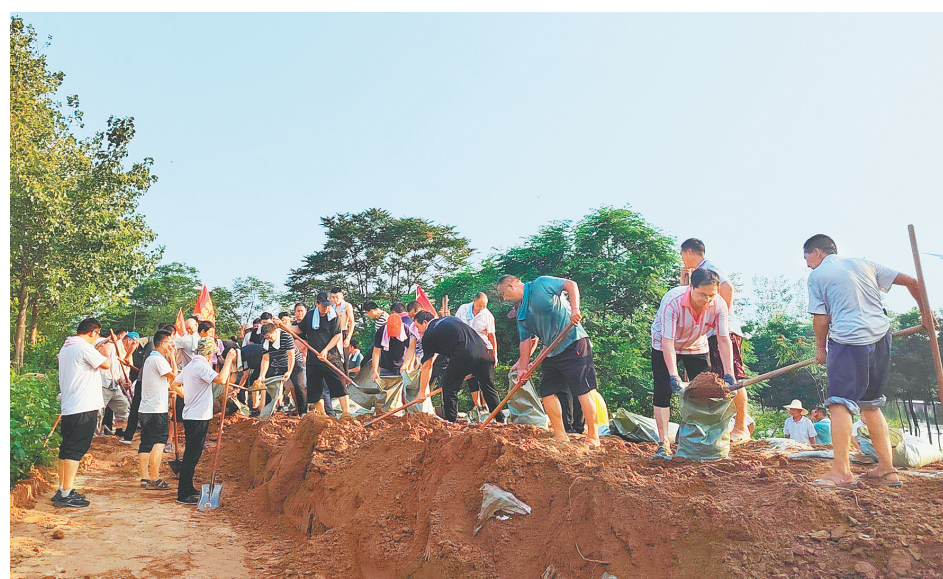
二安镇组织抢险救援人员加高加固防洪堤
